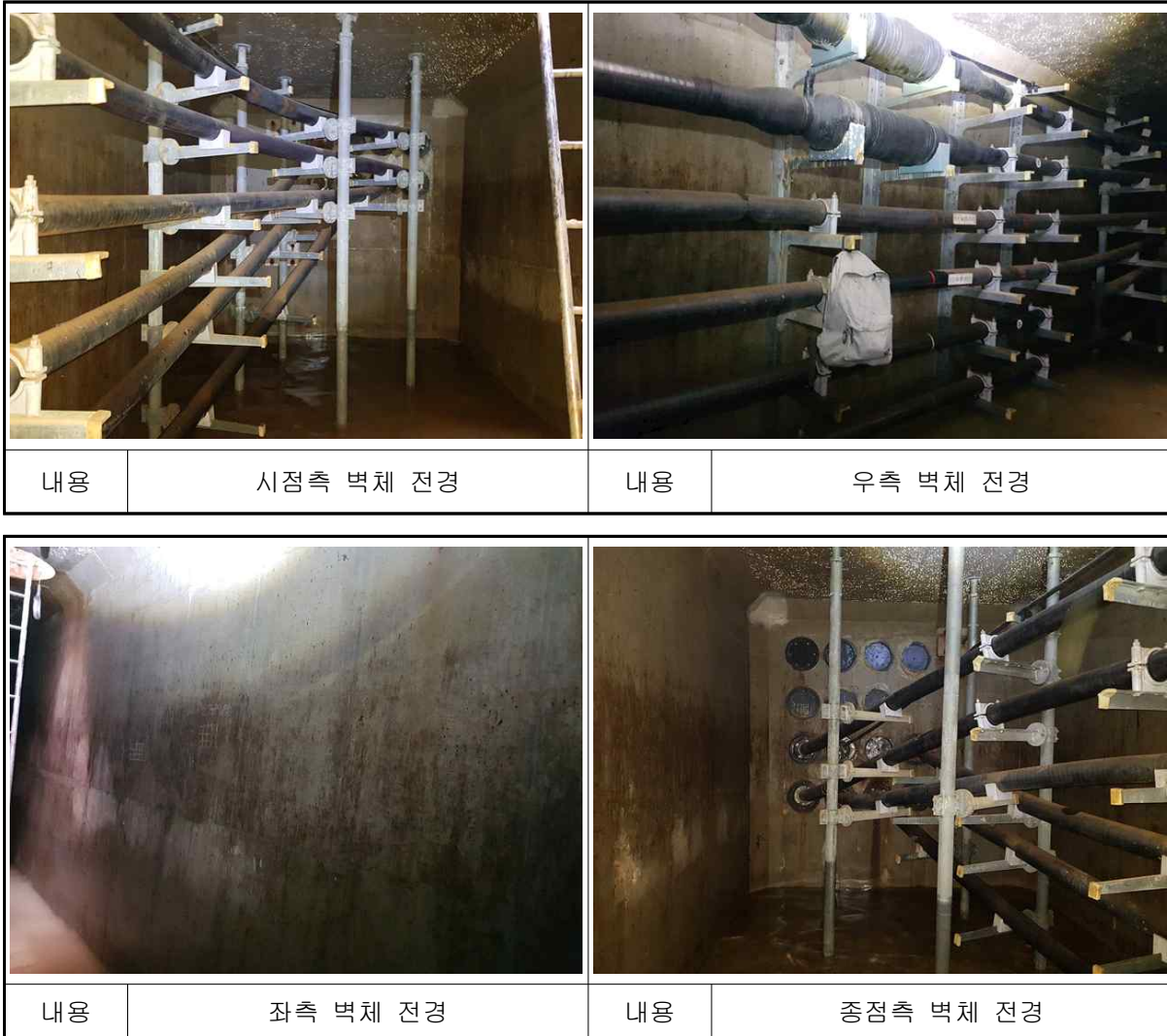
【사진 5.9】 수색 #By Pass 전경
