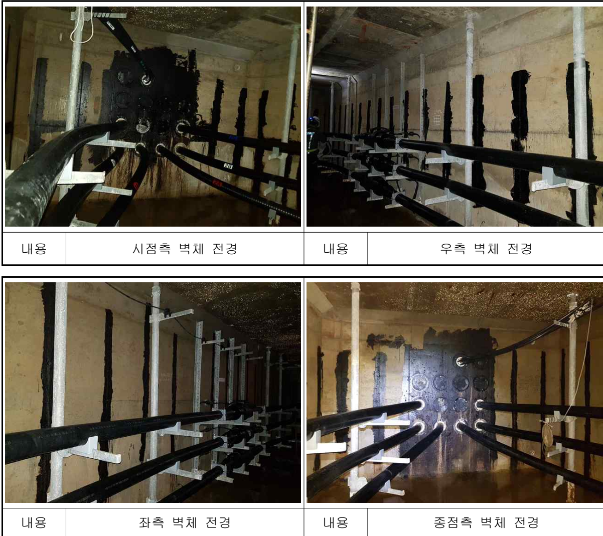
【사진 5.17】 원형 #2 전경
