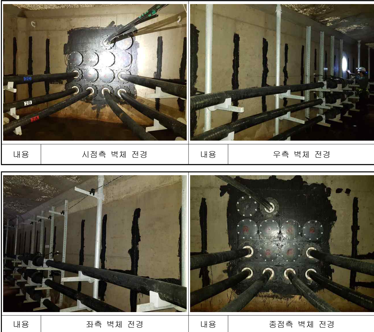
【사진 5.13】 원형 #1 전경
